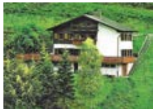
Das Bild, das es auch als Ansichtskarte gibt, zeigt die Skihütte im Calmbachtale im Jahr 1990; deren äußeres Gesamtbild unterscheidet sich kaum vom 1975 abgebrannten Vorgängerhaus.
