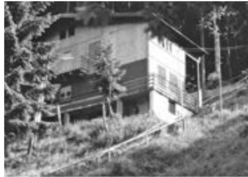
So präsentierte sich die Skihütte der Skizunft Calmbach, bevor sie am 14. Dezember 1975 ein Raub der Flammen wurde.
