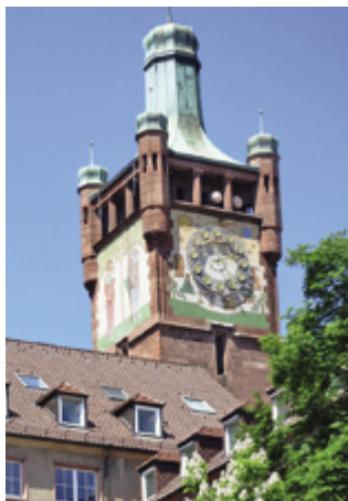
Der nach Kriegsschäden wieder originalgetreu gestaltete Bezirksamtsturm an der Bahnhofstraße mit badischem Wappen an der Straßenfront in der Dreitälerstadt steht am Sitz des einstigen badischen Bezirksamts Pforzheim.
