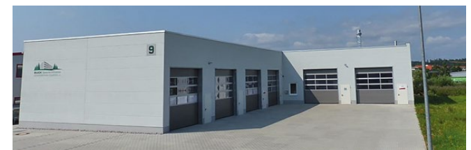
Auf dem Dach der Firma Buck in Unterhaugstett installiert der Bad Liebenzeller Arbeitskreis Energie eine Photovoltaik-Anlage, die jährlich mehr als 60.000 Kilowattstunden liefern wird.
